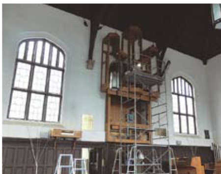
全てのパイプが外された様子
